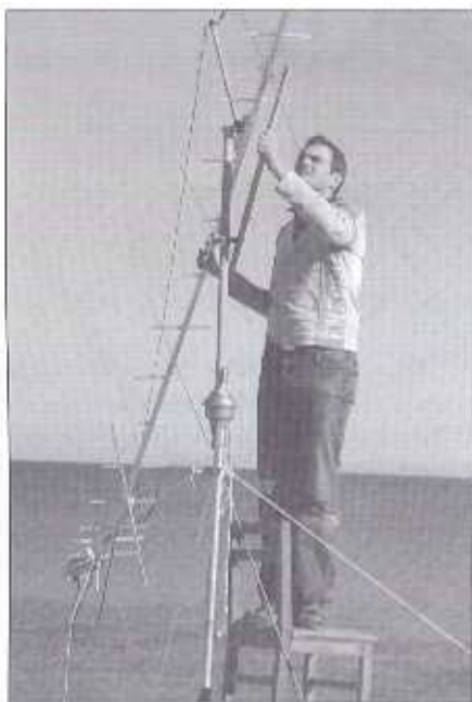
DL8YHR installs a 2 meter Yagi.
